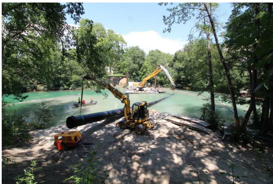
Travaux de la traversée du Lez - Navitau
