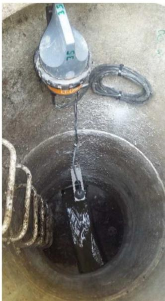
Sonde de mesure de hauteur d'eau
