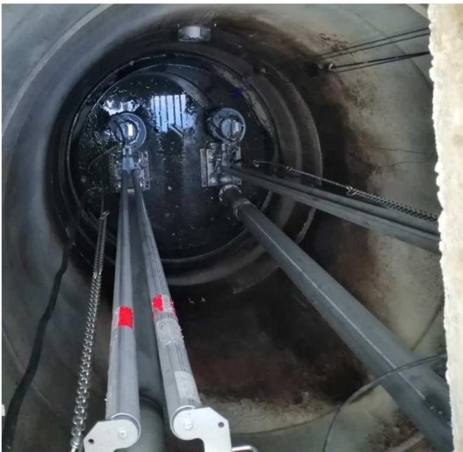
Ces ouvrages servent à pomper les eaux arrivées gravitairement dans un point bas pour les acheminer vers un point plus haut, afin de permettre leur écoulement vers la station d'épuration. La densité de postes est donc naturellement plus importante sur les communes au relief peu accentué.
