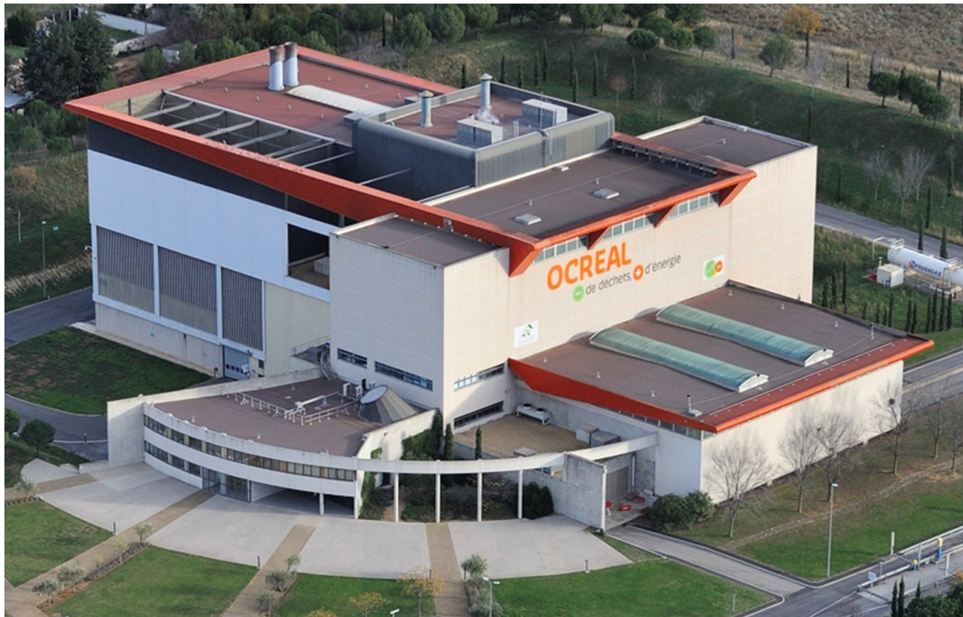
Unité de valorisation énergétique OCREAL
