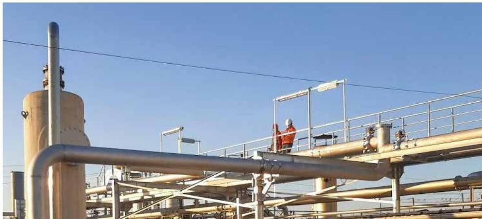
L'ensemble du réseau de valorisation a été positionné en toiture afin d'en faciliter la maintenance et la surveillance.
