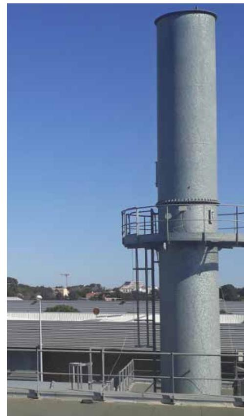
Cheminée commune de rejet des biofiltres 1 et 2 avec passerelle d'accès pour réalisation des mesures de contrôle
