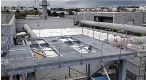
La mise en place d'une plateforme équipée de torchères à haut rendement permet d'accroître le niveau de sécurité de l'installation. Ce chantier relativement complexe s'est parfaitement déroulé sur la période fin 2019 et début 2020. Les torchères ont été construites dans le respect des règles SIL2 qui garantissent un haut niveau d'efficacité face au risque de défaillance.
