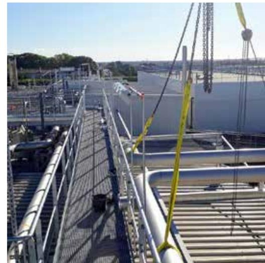
Mise en place des lyres de dilatation et passerelle de circulation pour la surveillance du réseau
