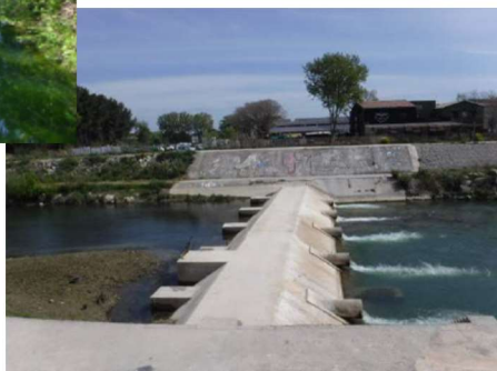
Station 2 : Pont Trinquat (aval Montpellier)
